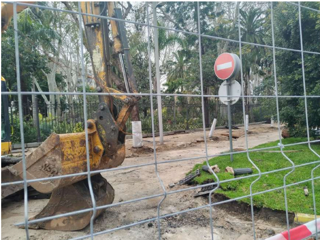
Imagen de archivo de las obras de Blas Infante. Algeciras renueva unos 100 metros de la red de abastecimiento en la avenida Blas Infante
