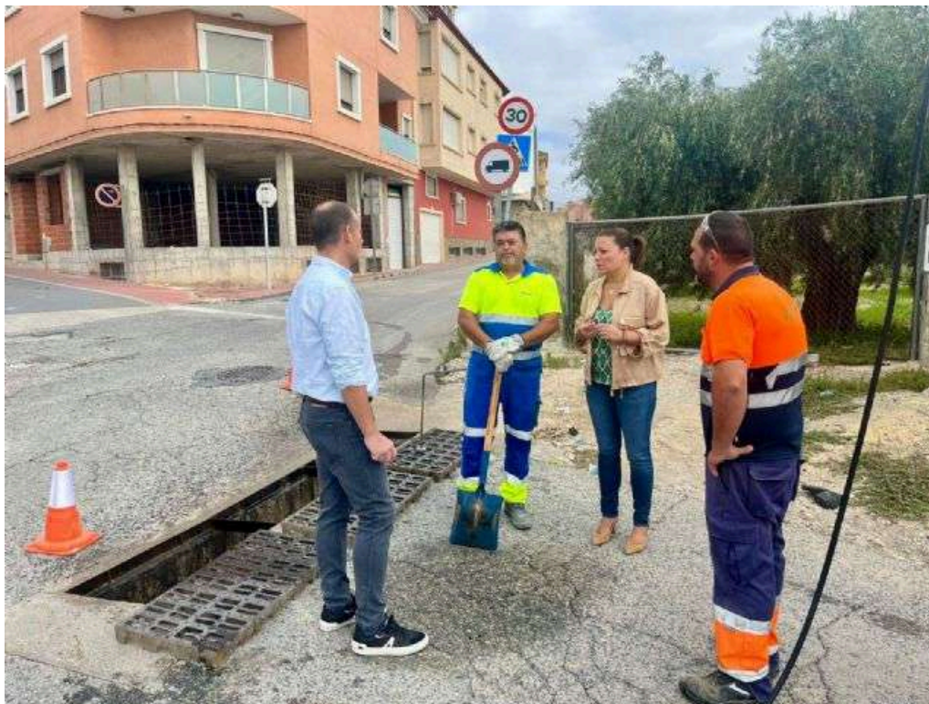
La alcaldesa de Fortuna supervisa los trabajos de limpieza del alcantarillado para prevenir inundaciones ante la llegada de las lluvias - 1, Foto 1
