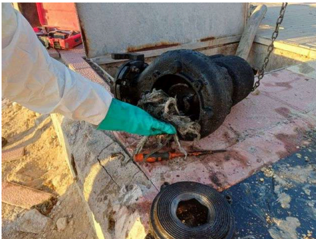
La alcaldesa de Fortuna supervisa los trabajos de limpieza del alcantarillado para prevenir inundaciones ante la llegada de las lluvias - 3, Foto 3
