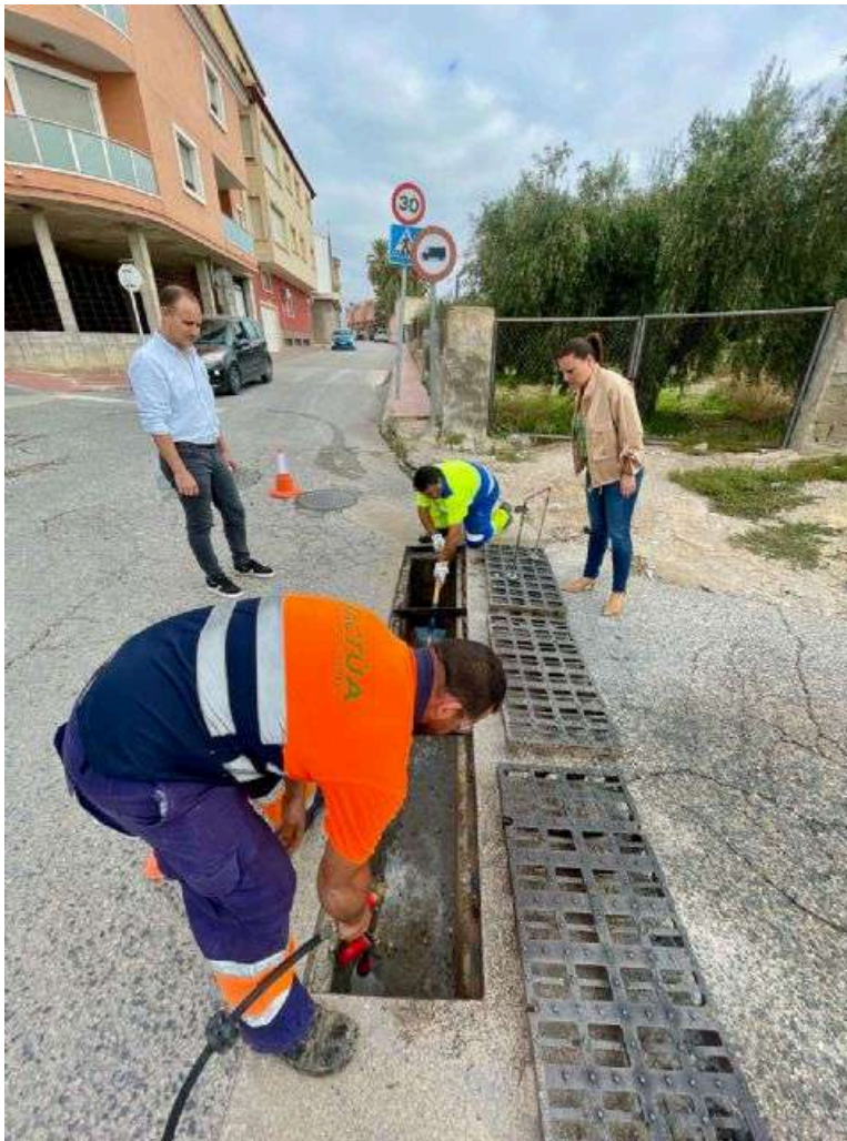
La alcaldesa de Fortuna supervisa los trabajos de limpieza del alcantarillado para prevenir inundaciones ante la llegada de las lluvias - 4, Foto 4
